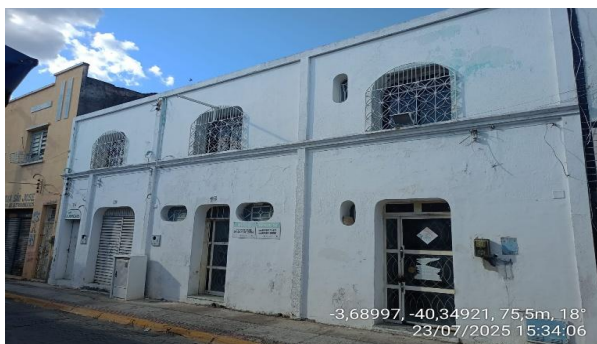
Foto 3 - Fachada do imóvel
