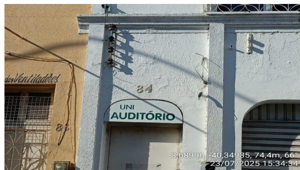
Foto 4 - Fachada do imóvel nº 84
