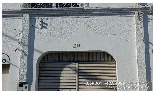
Foto 7 - Fachada do imóvel nº 82
