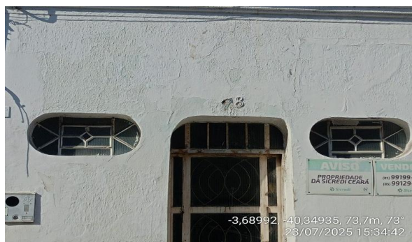
Foto 5 - Fachada do imóvel nº 78
