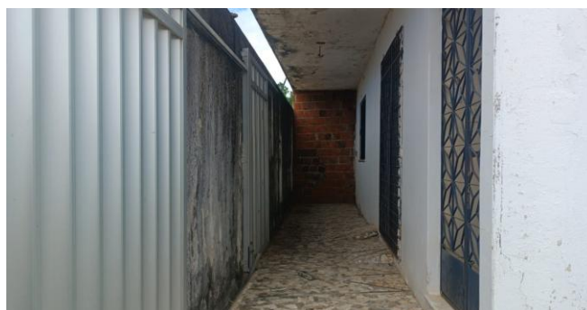
Foto 12 - Corredor lateral com acesso ao pavimento superior
