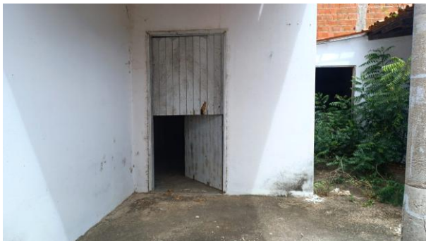
Foto 25 - Vista do imóvel
