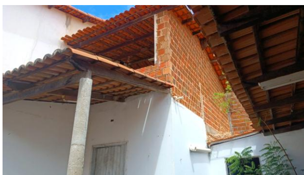
Foto 32 - Construção inacabada nos fundos
