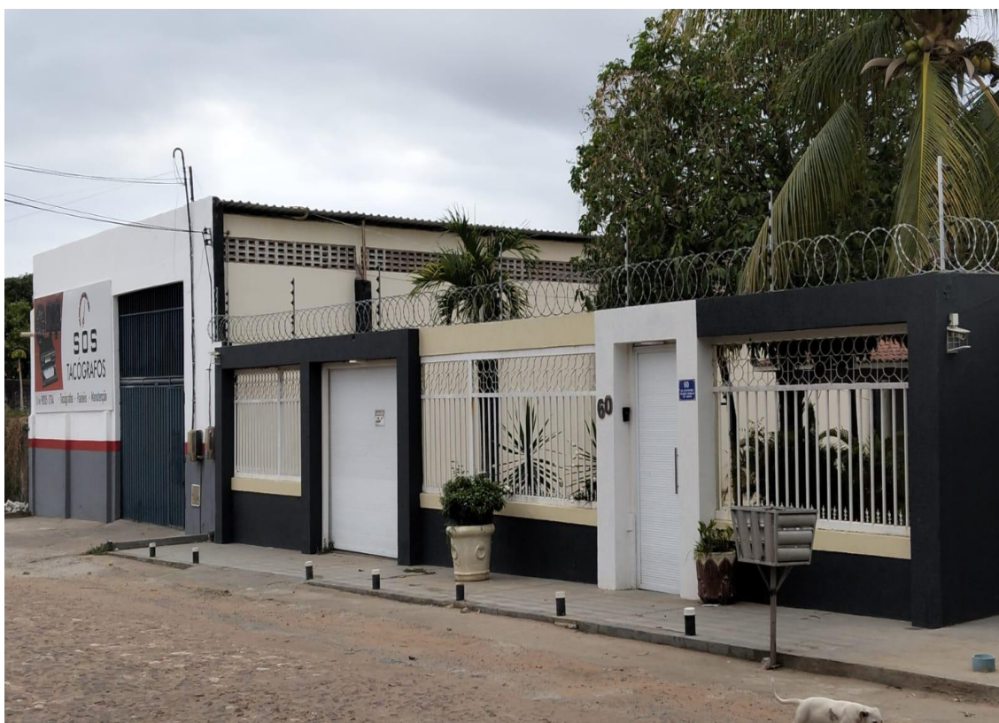
Foto 05 - Imóvel avaliando (Galpão e Casa Residencial) a casa residencial tem numeração nº 60
