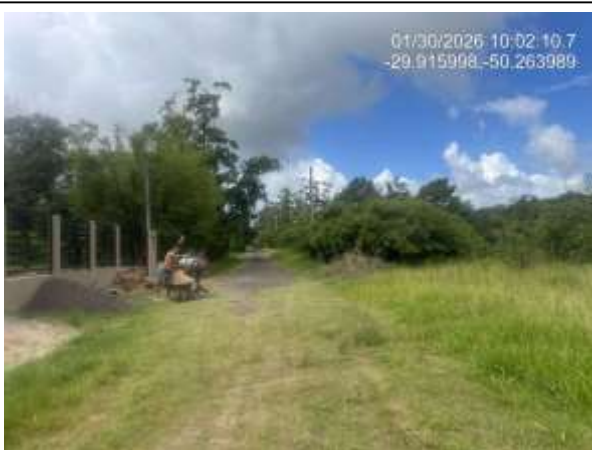
Acesso visto pela esquerda do terreno
