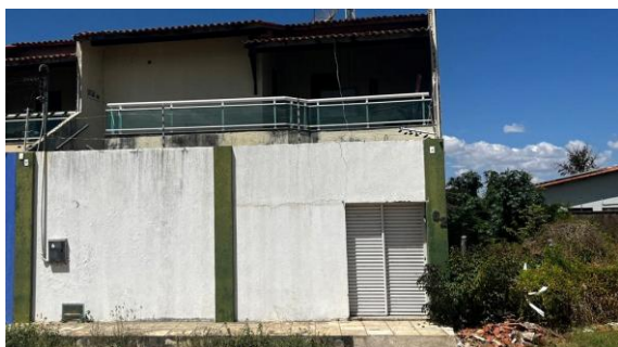
Foto 7 - Cerca elétrica do imóvel está danificada e imóvel ao lado de terreno baldio
