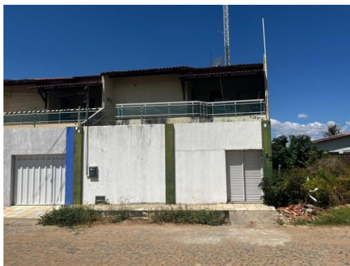
Foto 4 - Vista do imóvel avaliando
