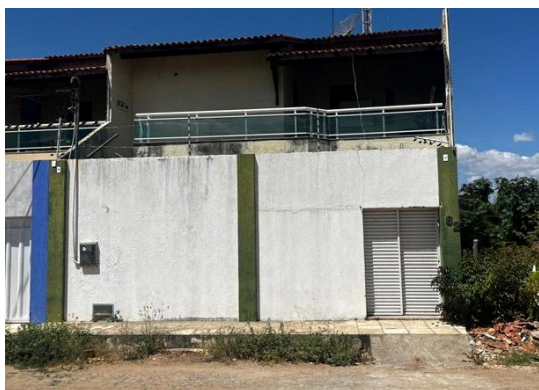
Foto 5 - Vista do imóvel avaliando
