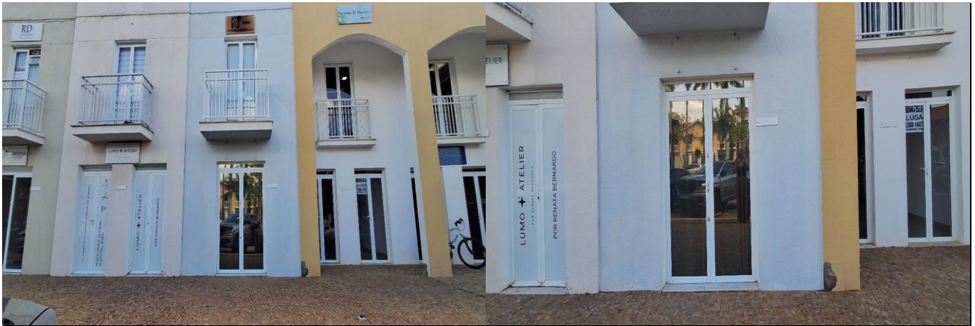
FACHADA DO EDÍFICIO
