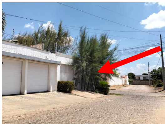
Foto 3 - Seta indicando imóvel avaliando situado em esquina
